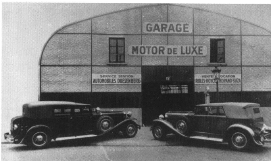
Motor de Luxe service garage, 12 rue de Sablonville, Paris.
